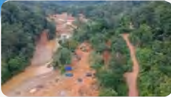
Kerusakan Daerah Aliran Sungai Akibat PETI
